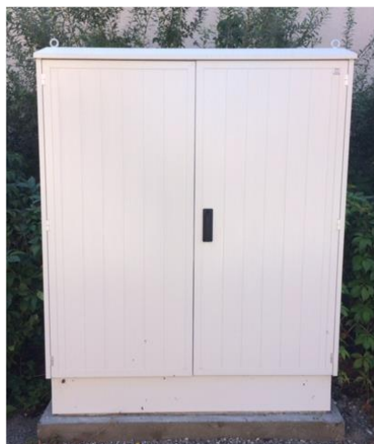
Slika 2. Prikaz ormara tipa Cabinet AP-DD, 2P Tel
